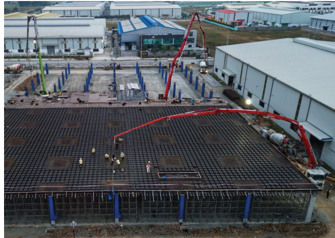
12 Dự án cung cấp bê tông tươi phục vụ công trình công nghiệp tại Sóc Trăng
