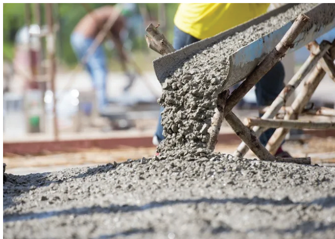
08 Dự án cung cấp bê tông tươi cho khu dân cư tại Sóc Trăng
