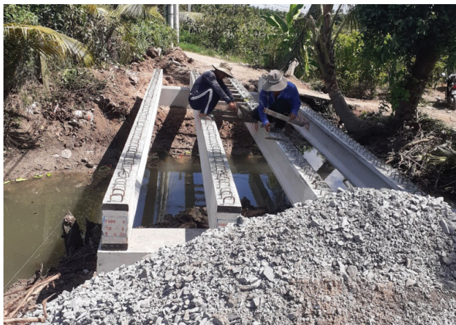
07 Dự án cung cấp bê tông tươi thi công cầu dân sinh tại Bạc Liêu
